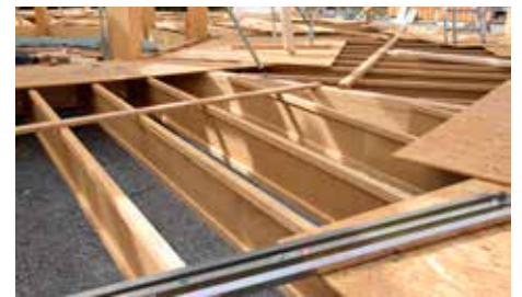
Bjälklaget av lättbalk ska isoleras med termoträ.
