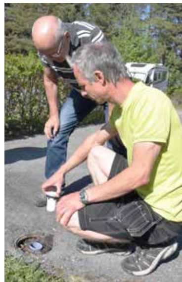
Spillvattentanken töms via slang i avloppet. Vattenlåset är en golvbrunn för anslutning av handfat.
